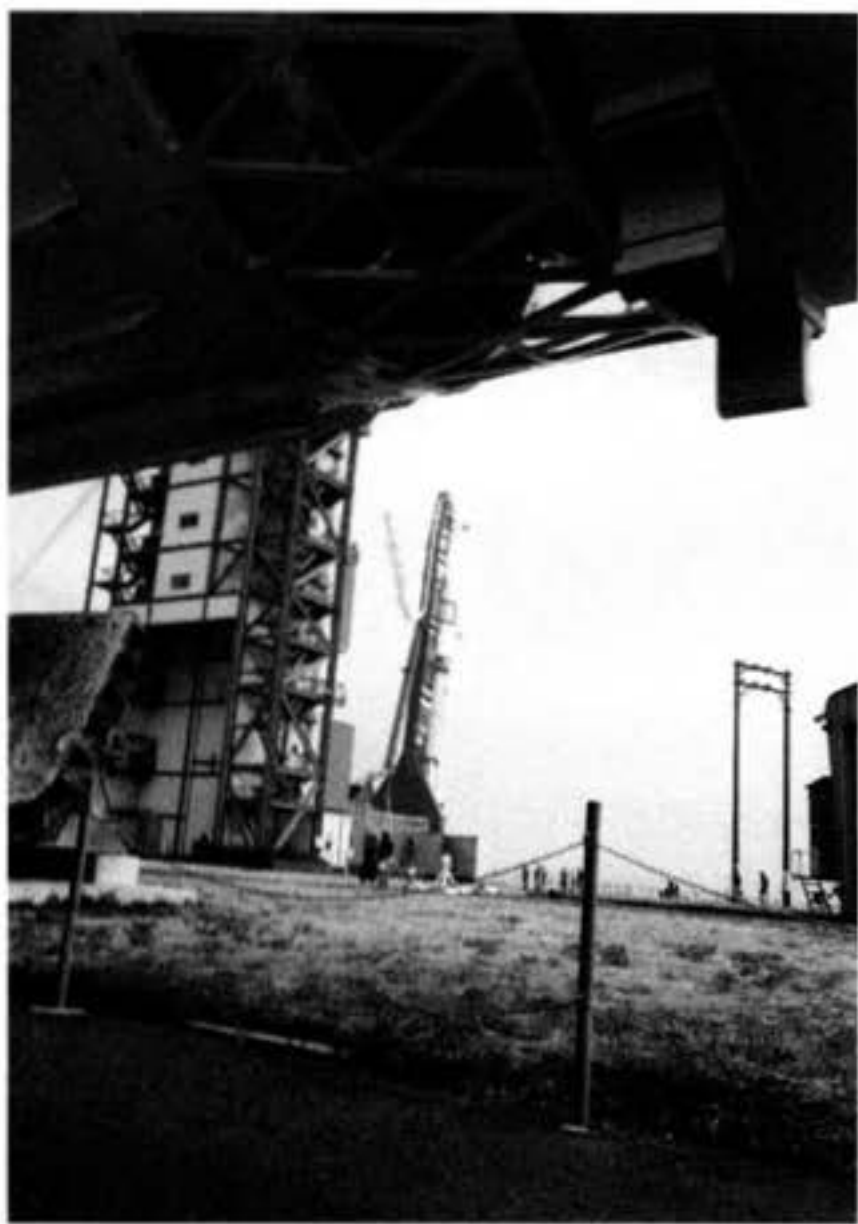
電波テスト当日のM-Vロケット1号機。上に写って いるのは展示されているM-V地上試験機
