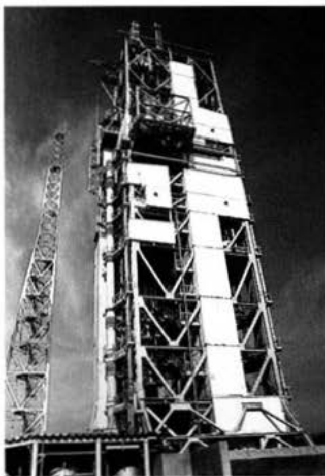
発射台を裏側から見る。H-IIの時に使ったPSTの壁面がそのまま使われている
