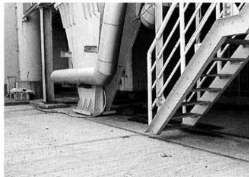
移動発射台の基部。階段の先にあるのが四本ある足のひとつ
