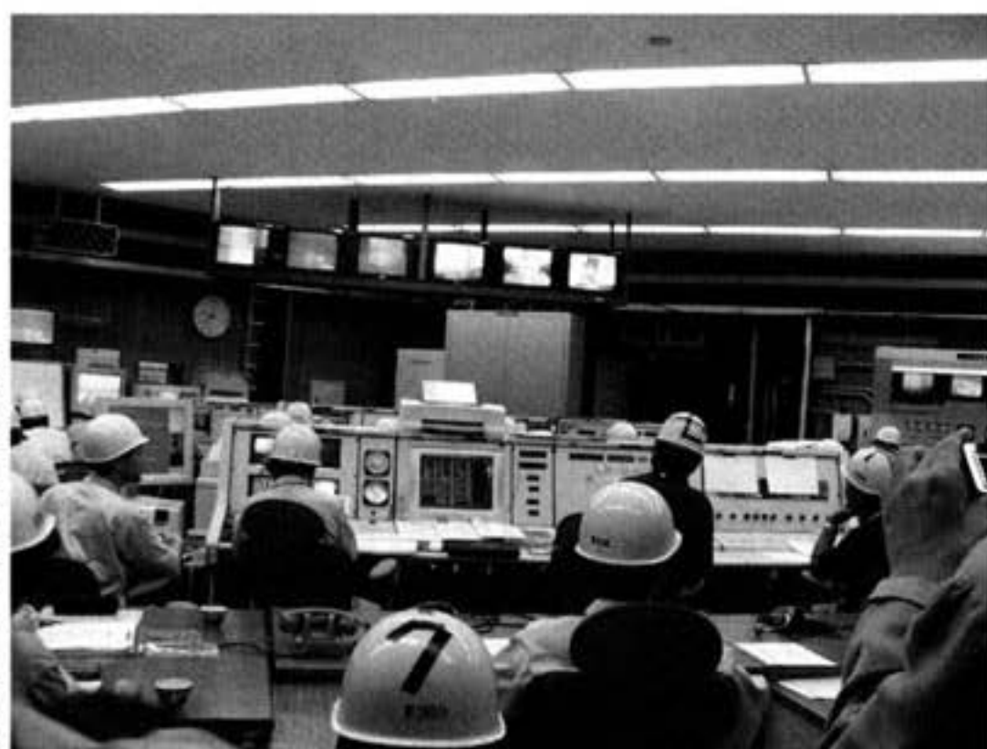
地下発射管制室の入口と内部
