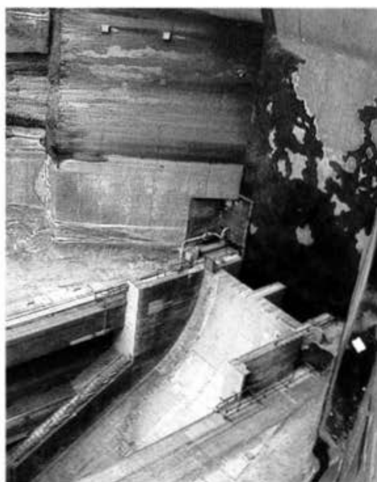
上・LE-7やLE-7Aのような大型エンジンの地上燃焼実験を行うための設備 下・試験設備の下には噴射炎を受け止めて海側に流すためのデフレクターが掘り込んである
