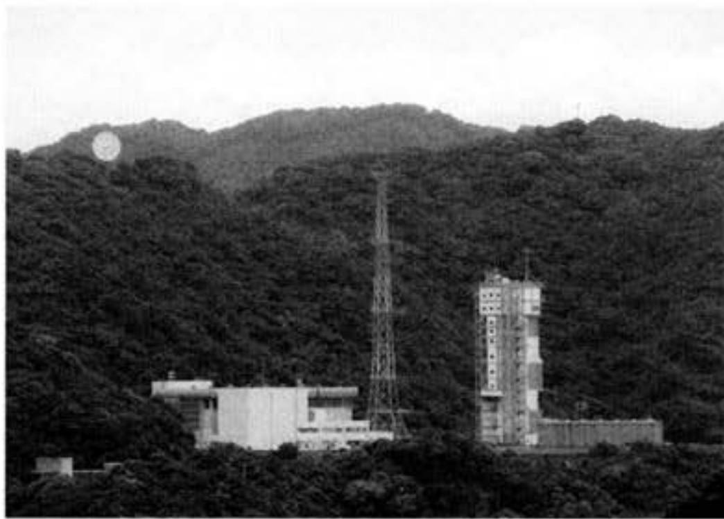
打ち上げ翌日。ランチャーは整備塔に戻り、宇宙センターは静かな田舎の風景になる
