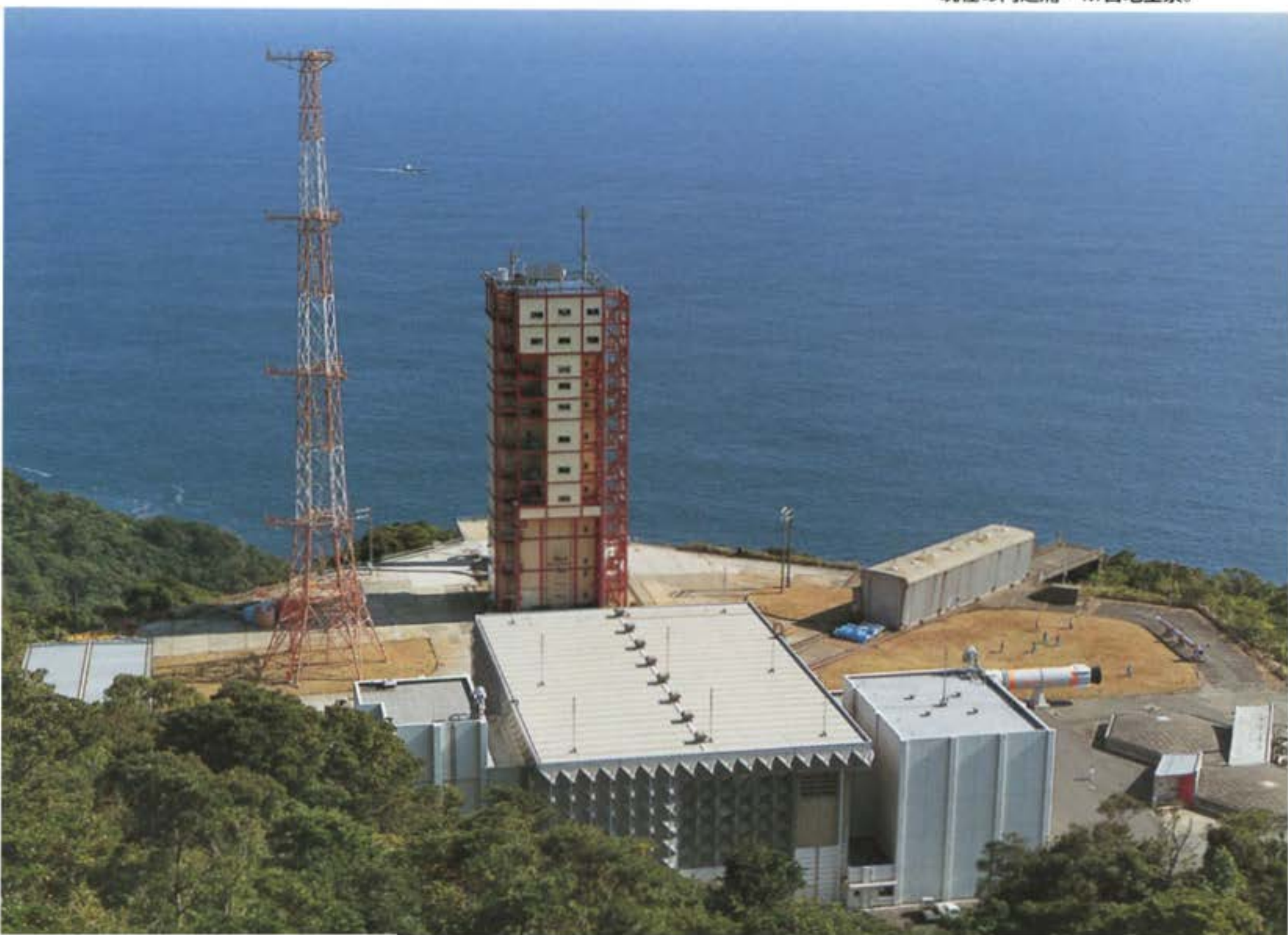
現在の内之浦・M台地全景。
