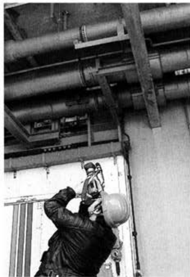
発射台の推進剤用の配管を撮影中
