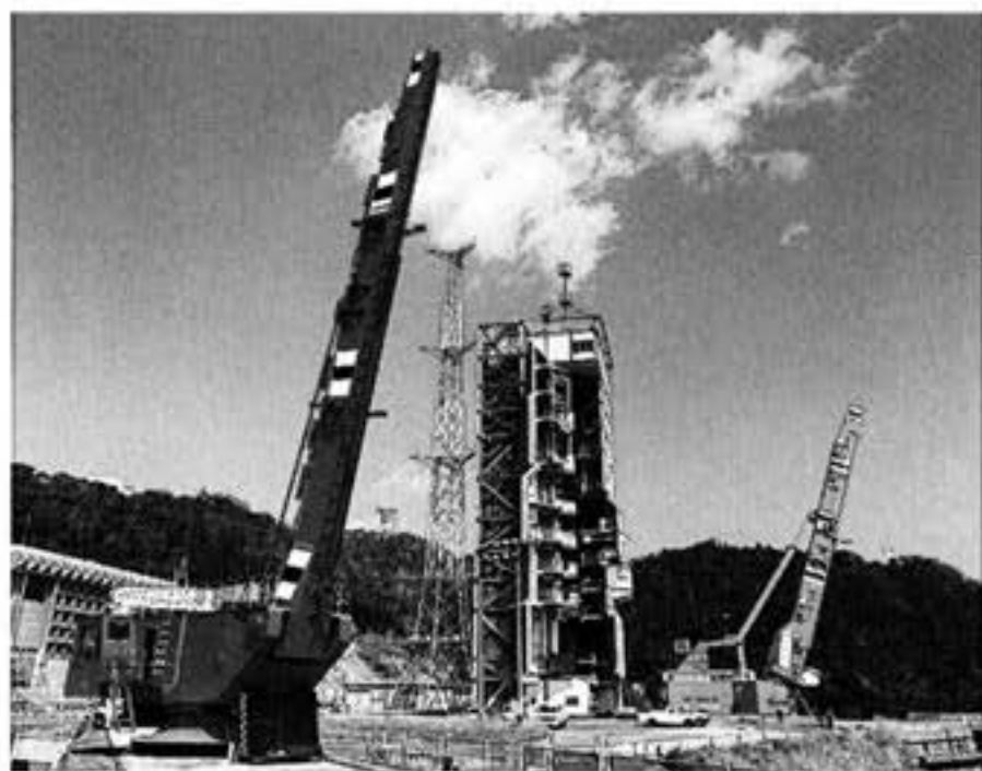
左手前がラムダロケットのランチャー、右奥にあるのがミューロケットのランチャー
